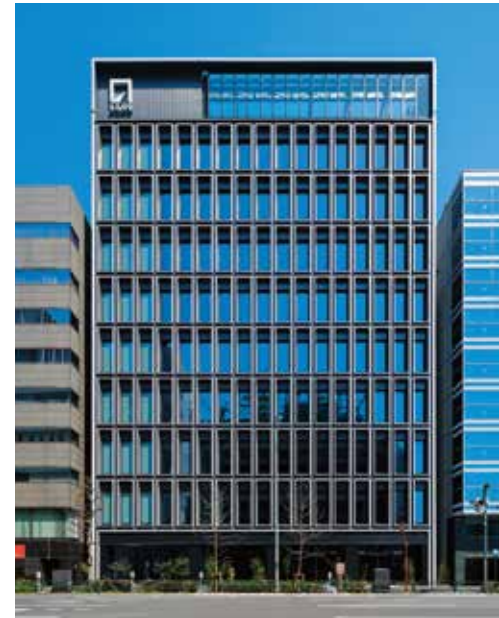
S-GATE 大手町北
